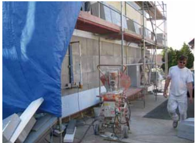
.. nun wird die Dämmung angebracht und anschließend neu verputzt.
