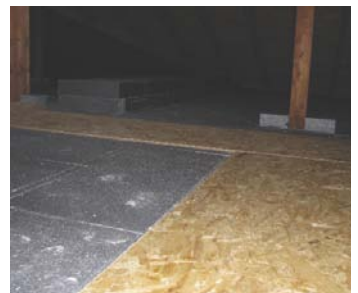
Dachbodendämmung mit Verbundplatten
