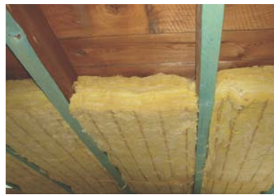
Aufdopplung der Sparren um die Dämmstärke zu erhöhen
