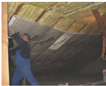
Dachdämmung durch Zwischensparrendämmung
