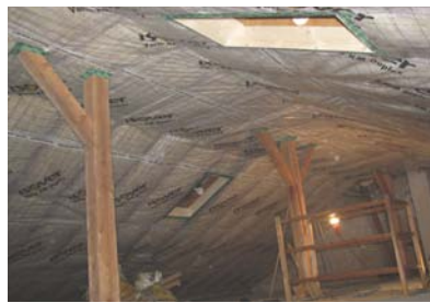
Dachdämmung durch Zwischensparrendämmung
