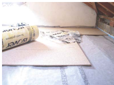
Dachbodendämmung mit Mineralwolle
