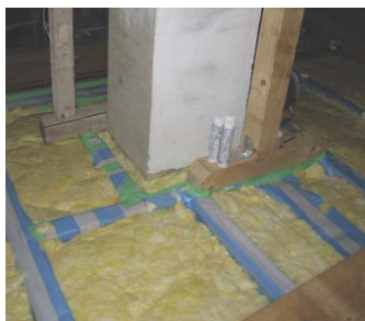
Dachbodendämmung mit Mineralwolle
